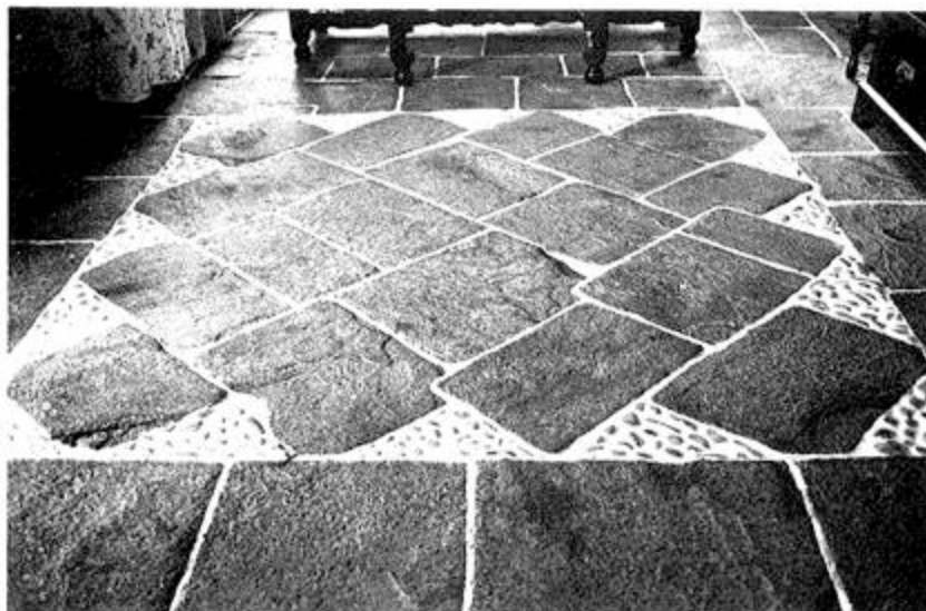
Εικ. 150. Δάπεδο σάλας μέ σχιστόπλακες και βότσαλα.
