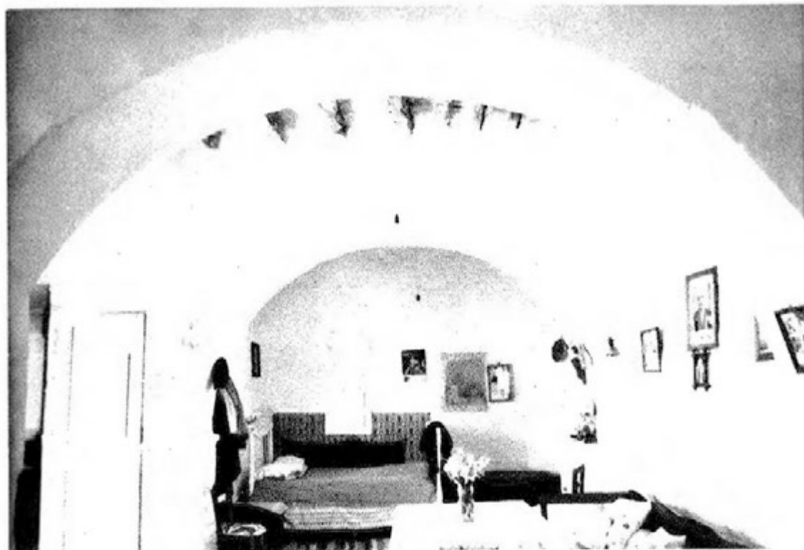
Είκ. 32. Φέρουσα κατασκευή με «βόλτα».
