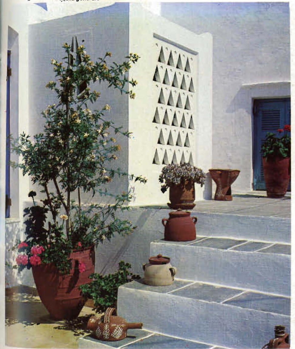
↑ Λεπτομέρεια δψης σπιτιού Detail of a house facade Teilsnsicht eines Hauses Detail de la facade d' une maison Dettaglio della facciata di una casa
