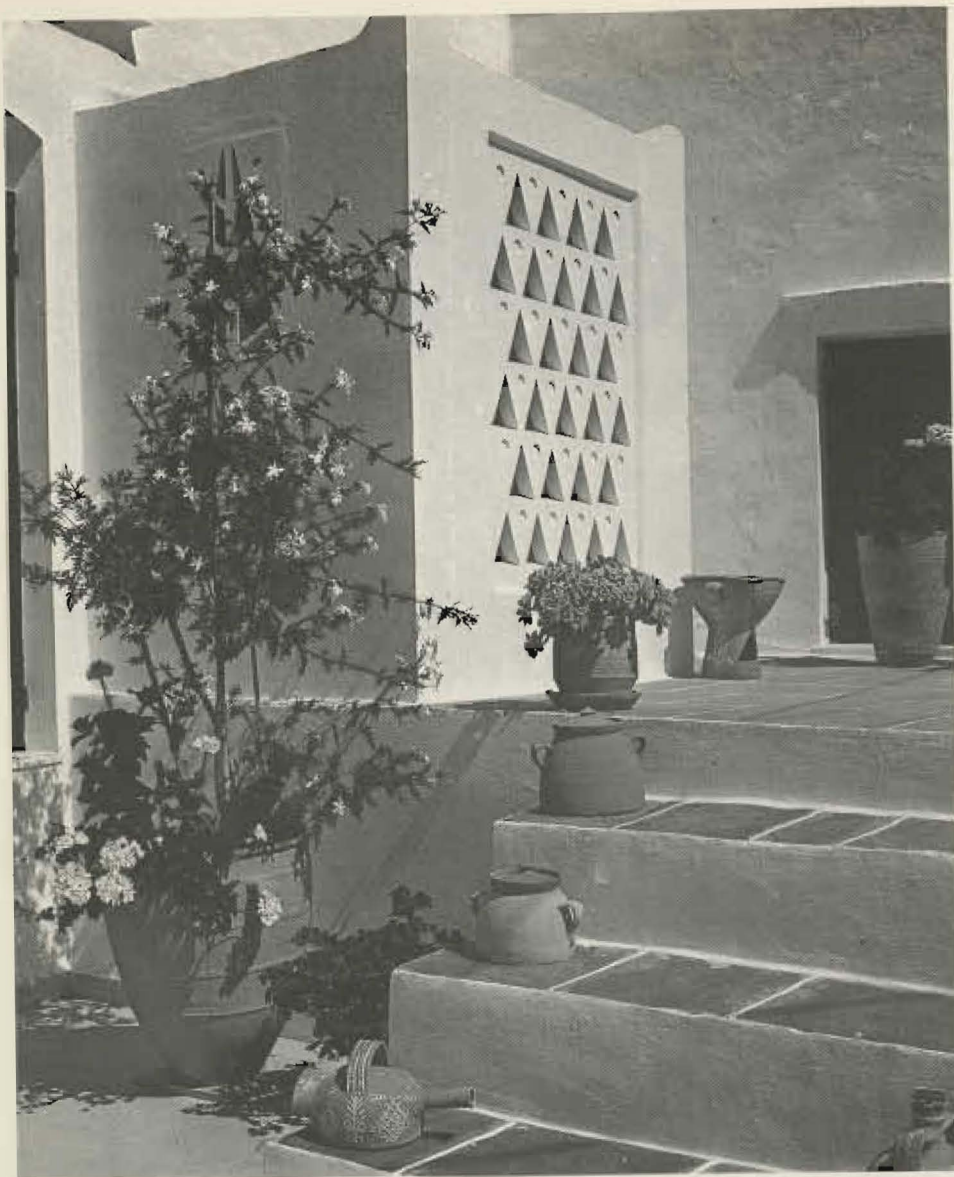
Είσοδος πλακόστρωτης ούλης. Φτιάχνοντας άρμούς Entrance of a paved courtyard - Making the joints Der Eingang eines mit Platten belegten Hofes - Fugen schaffend Entrée d'une cour pavée. Effectuant les joints Entrata di uno cortile lastrato - Facendo le congiunture
