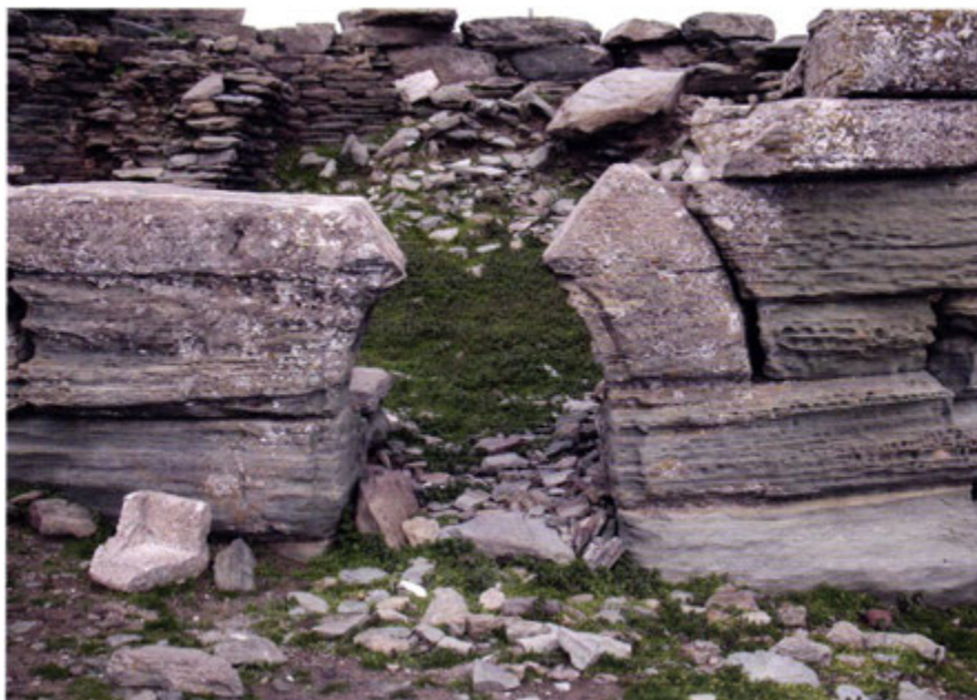
Εικ. 87. Πύργος «Στον Άγιο Δημήτριο Αρχαβόν» ή «Μαύρος Πύργος»: η αφίδεστού τύπον θύρα, από νότια (αρ. 27, 5ος αι. π.Χ.).
