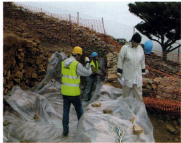
Εικ. 13. Η γράφουσα με το συνεργείο του έργου σε εργασίες στο εσωτερικό τείχος το 2003. Διακρίνονται οι Σίφνιοι εργάτες Ανδρέας Αρμελινός και Γεώργιος Ν. Χρύσος.
