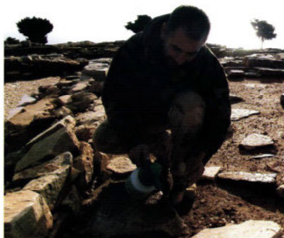
Εικ. 25. Εργασίες στερέωσης σε κονίαμα στο Ιερό από τον συντηρητή αρχαιοτήτων Γιάννη Σταϊκόπουλο.
