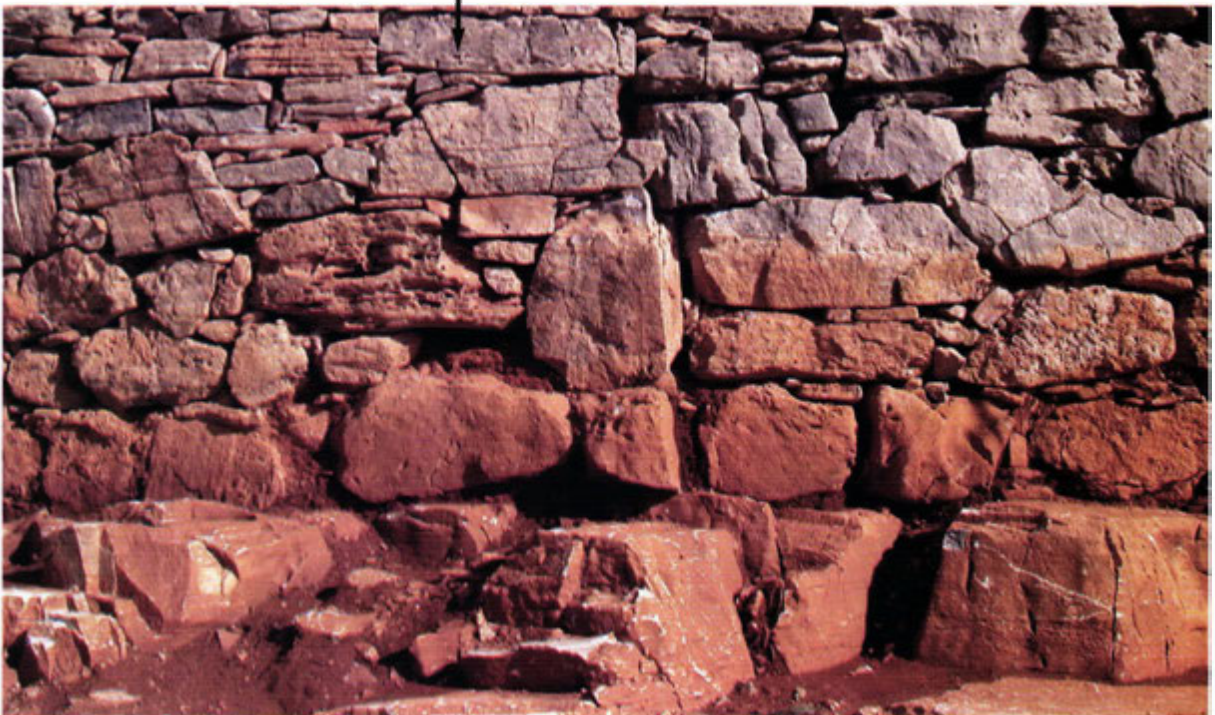
Εικ. 23. Το τμήμα του τείχους της εικόνας 22 μετά τις εργασίες στερέωσης.
