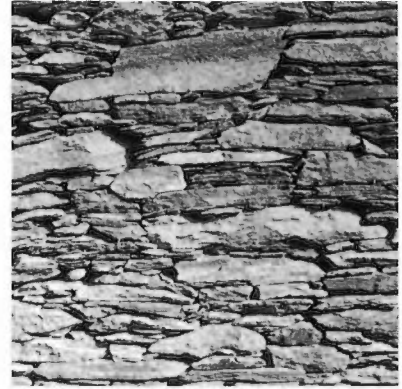
2 Τοικοποιία από σχιστόλιθο (Αποκοφτό 1)
