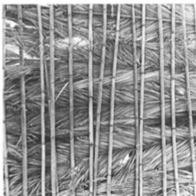
1 Οροφή από καλάμια (μπαγδατί) (Πλατύς Γιαλός 12)
