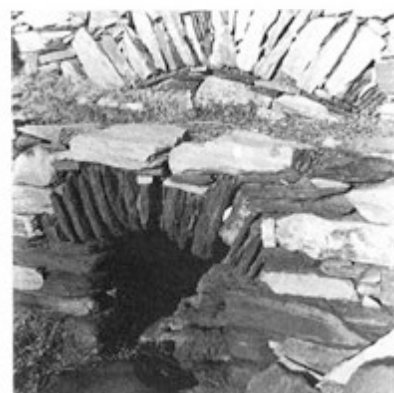
7 Άνοιγμα για πυροσκάλεμα και φούρνος ψωμιού
