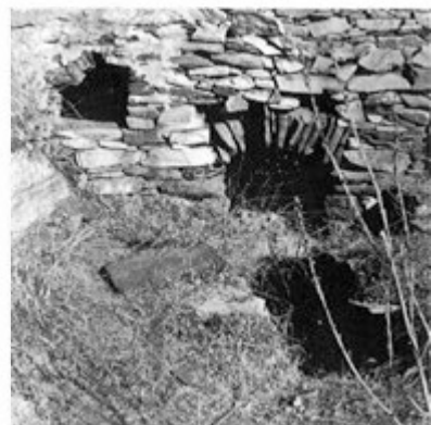
9 Ανοίγμα ανασκαλέματος φωτιάς, αυλάκι στάχτης και φούρνος ψωμιού (Φάρος 7)
