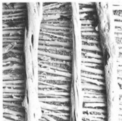
4 Οροφή με ξύλινα δοκάρια και κλαδιά
