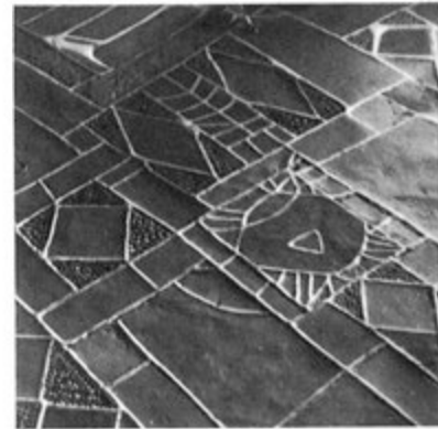
9 Επίστρωση δαπέδου σε μια εκκλησία του Κάστρο
