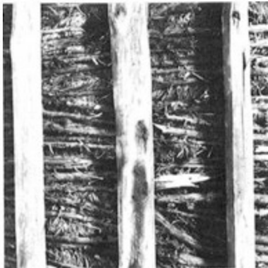
5 Οροφή με ξύλινα δοκάρια και κλαδιά
