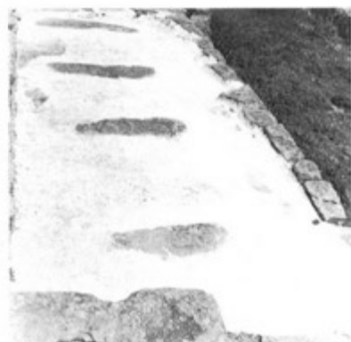
4 Οψη στέγης (Λαγκάδα)
