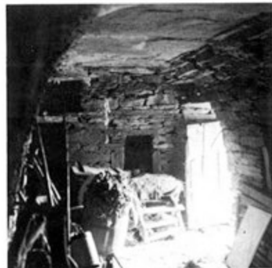
3 Πρόβολοι τοίχοι, στέγη από πλάκες σχιστόλιθου
