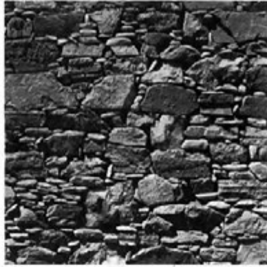
1 Τοικοποιία από ασβεστόλιθο (Πλ. Γιάλος)
