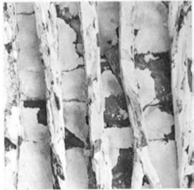
3 Οροφή με ξύλινα δοκάρια και πλάκες ασιτόλιθου
