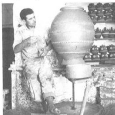
4 Κατασκευή πιθαρίου (Χερρόνσος 3)
