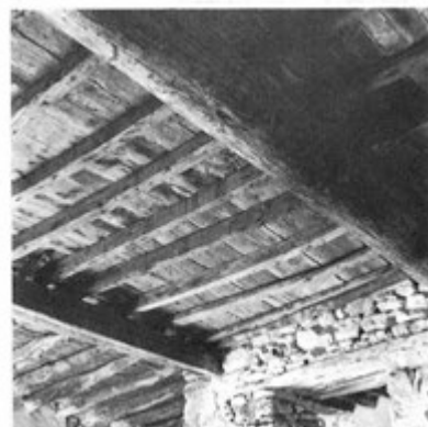
7 Οροφή με ξύλινα δοκάρια και σανίδια (Πλατύς Γιαλός)
