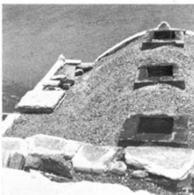
8 Ανοίγματα απαγωγής καπνού (Καμάρες 8)
