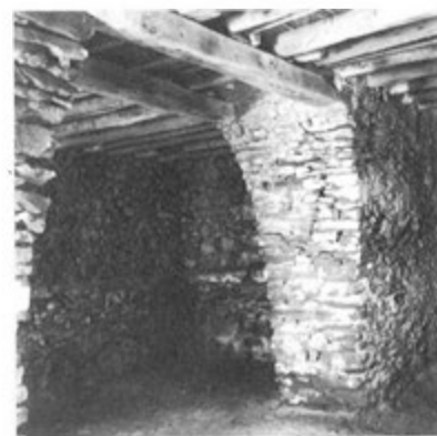
8 Φέρουσα τοικοποιία με δοκιδωτή οροφή (Χερρόνησος 8)
