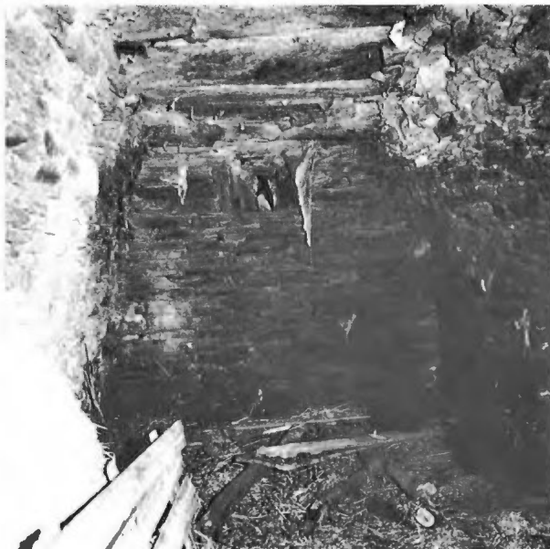
4 Υποσπρικτικοί τοίχοι στο Λαγκάδα 1 Γ
